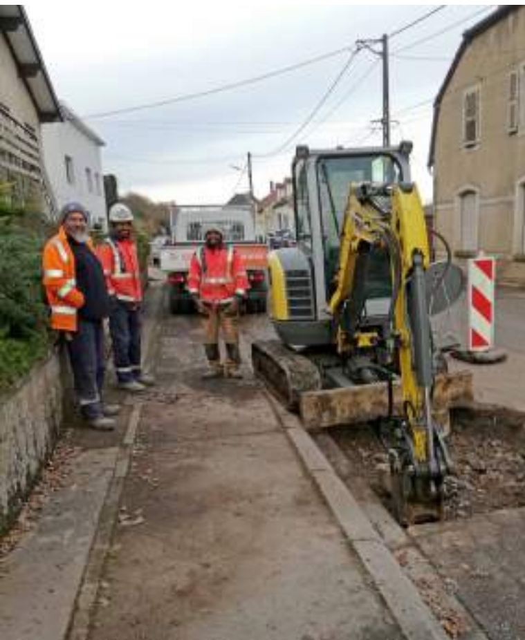
Travaux rue Principale
