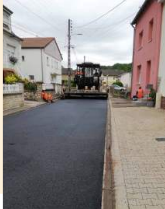
Travaux rue Beau Vallon
