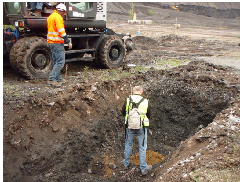
Fouilles pour localisation des réseaux de conduites
