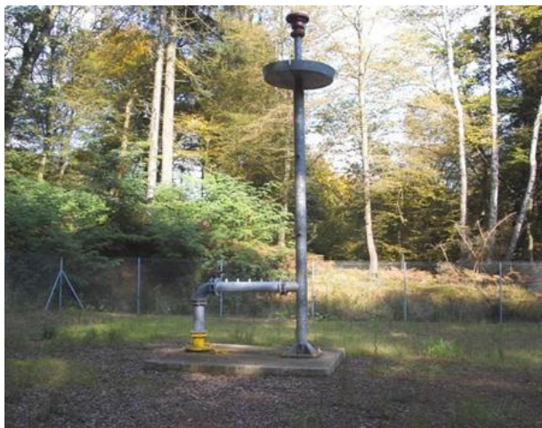
EXUTOIRE GAZ , relié sur un sondage de décompression (SDEC) ou directement sur un puits, en liaison avec un vide minier non ennoyé.
