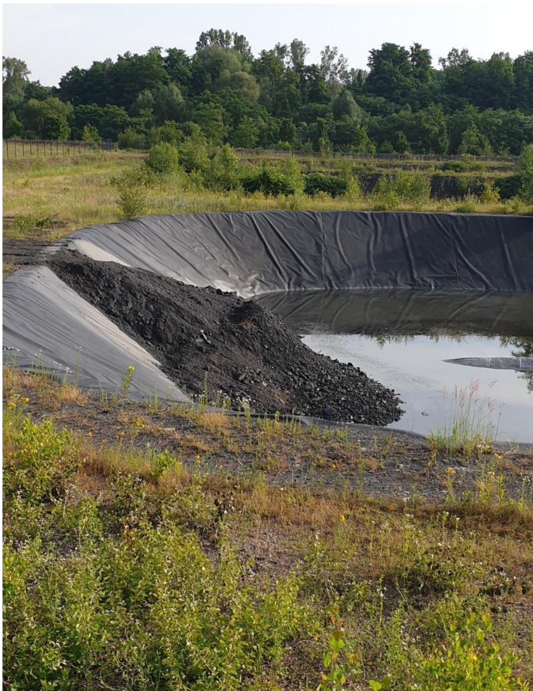
Figure 69 : Rampe de matériaux meubles mise en place dans le bassin bâché
